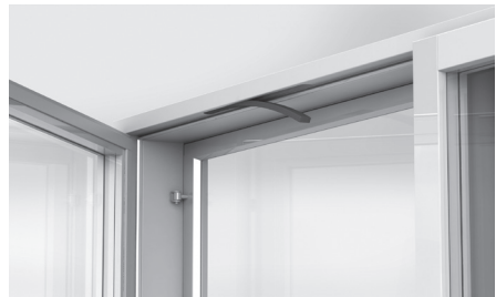
Suodattimen vaihto avattavassa ikkunassa.
